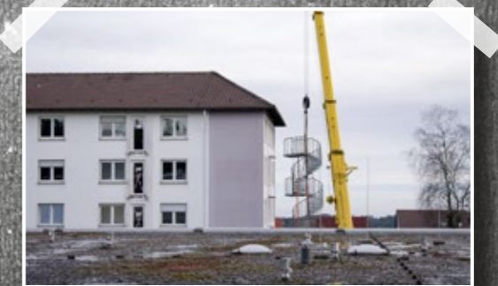
Der Einsatz schweren Geräts war nötig, um die Fluchttreppe am Gebäude J in Schömberg zu versetzen
